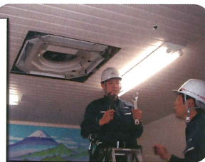
点検・サービス
